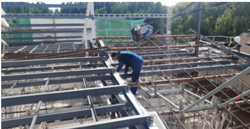
Obras de reforma, en el interior y en el exterior, en la cubierta de la Asamblea Regional
