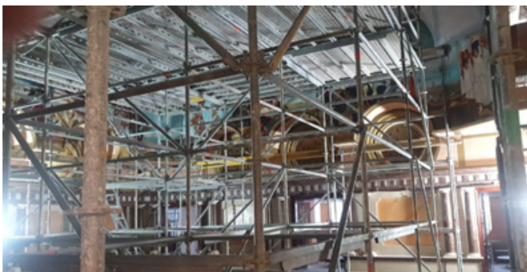
Estado del Salón de Plenos y del Patio de las Comarcas durante las obras de reforma de la cubierta y de las instalaciones conexas al Salón de Plenos de la Asamblea Regional
